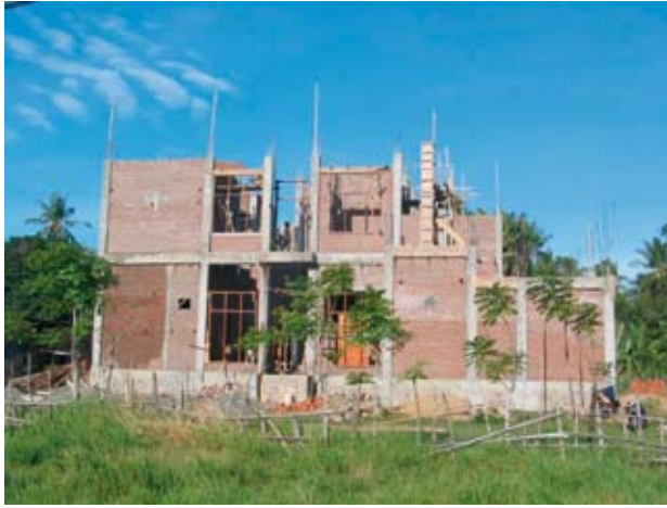
»2 Traditional housebuilding »2 Traditionelle Hausbauweise
